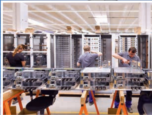
Teamwork: Am Bau der HPS-Schaltanlagen sind zahlreiche Fachkräfte beteiligt.
